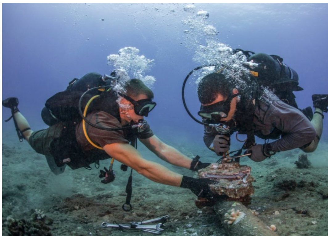
Mergulhadores removem ânodos de zinco corroídos de um cabo submarino perto do Havaí
