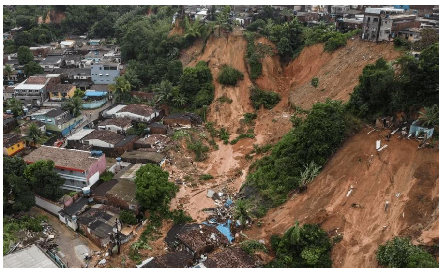
Figura 1: Deslizamentos que aconteceram em Recife devido fortes chuvas em maio de 2022
