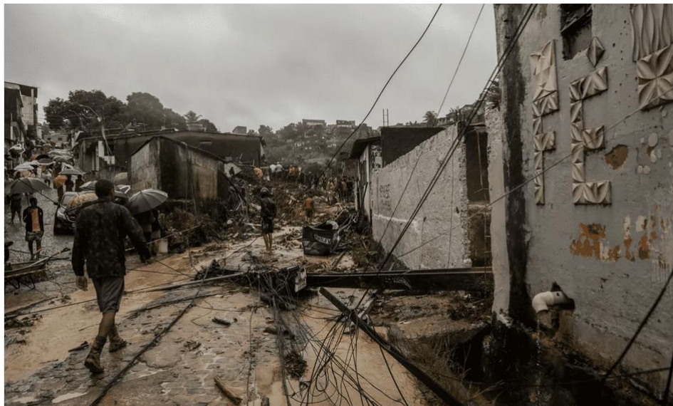
Figura 2: Danos causados pelas chuvas em maio de 2022
